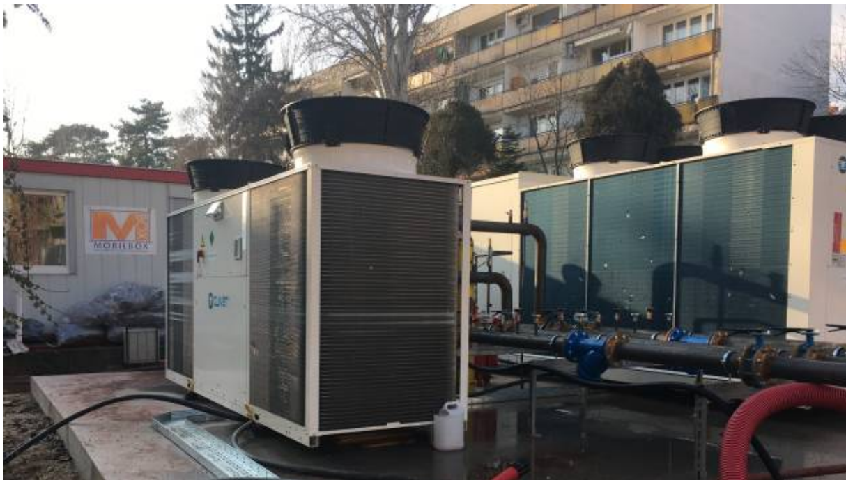
Kép baloldalán a WSAN-XIN mf 45.2 típ berendezés, a jobb oldalon pedig a WSAN-XEM 70.4 típ. berendezés
